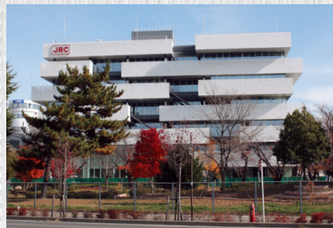
完成した「先端技術センター」
